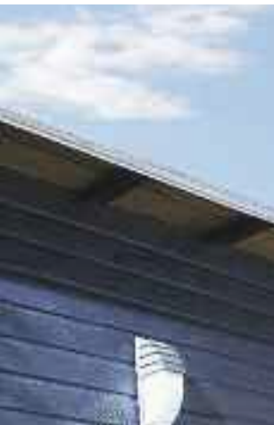
Bardage Métal Bleu Canon - Maison Individuelle (35)
