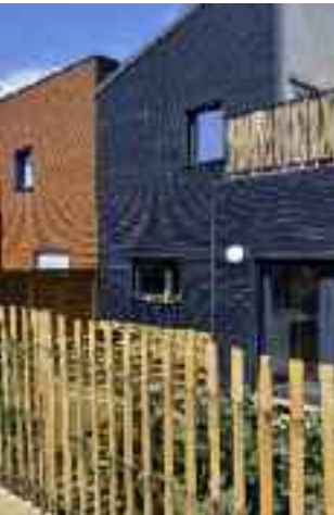
Bardage Natur Sable et Silver Lab' - Eco-quartier à Balainvilliers (91)
